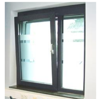
Bürogebäude einer Polizeistation.
