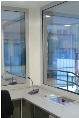
Innenansicht einer Pfortenanlage.
