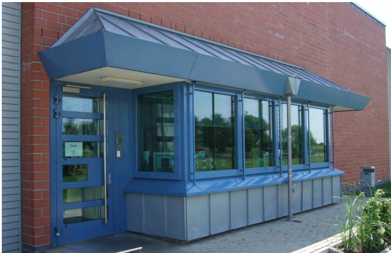
Außenansicht der Pfortenanlage einer Justizvollzugsanstalt. Die Sicherheitsstufen wurden gemäß Kundenvorgabe umgesetzt.
