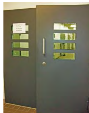
2 fgl. Flurtür aus Stahl mit Glasausschnitten in einer Polizeistation.
