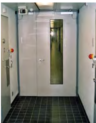
Flurtür aus Stahl mit Verglasung und Seitenteil für Polizeigewahrsam.
