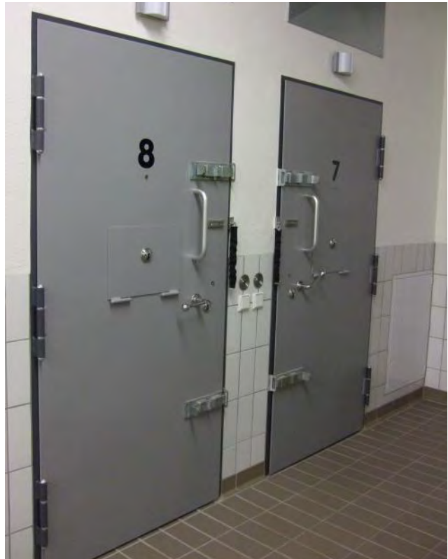
Gewahrsamtüren mit Kostklappe, Schubriegel, Handhebel und Sicherheitskette.
