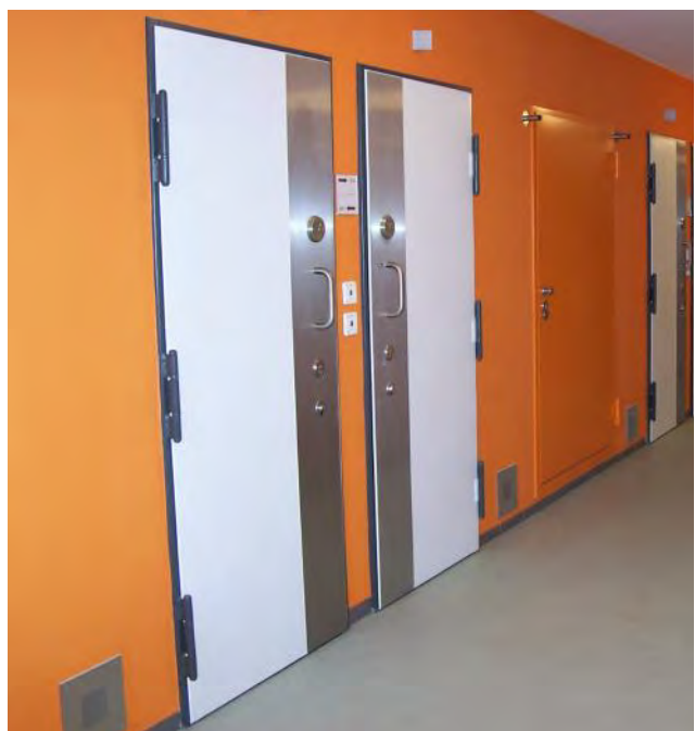
Zellentüren mit Edelstahlenschutzblech.
