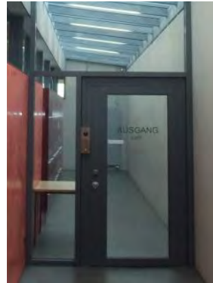
Flurtür in einer JVA.
