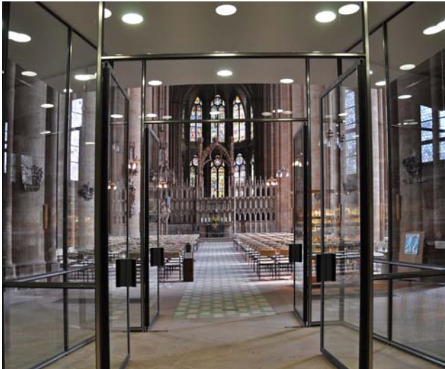
Fotos: Elisabethkirche in Marburg. Erbaut im 13. Jahrhundert, ist sie die früheste rein gotische Kirche Deutschlands. SÄLZER hat im Eingangsbereich einen Windfang in moderner Edelstahl-Sicherheitsglas-Konstruktion mit 3 m hohen Trennwänden mit mehreren Türein- und -ausgängen gebaut.
