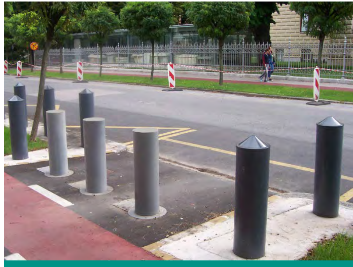
Kombination feststehender und versenkbarer Poller.
