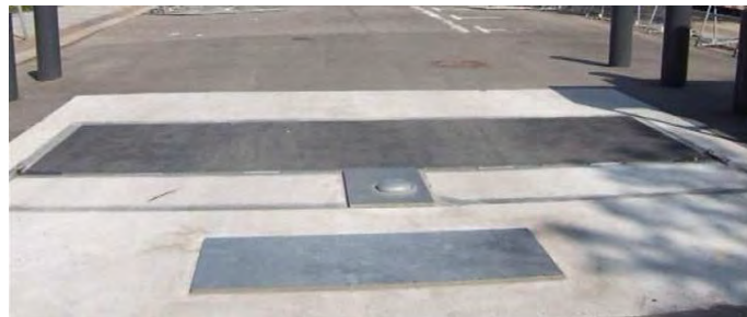
Barriere: Im geschlossenen Zustand flächenbündig mit der Fahrbahn. Geöffnet: Standardhöhe 900 mm.
