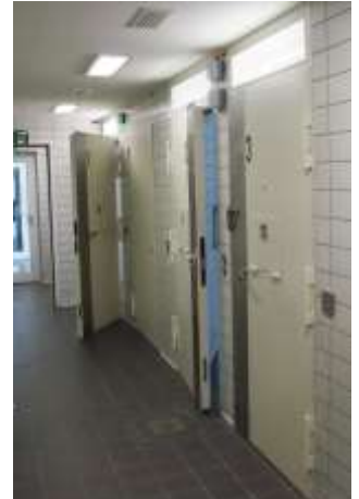
Gewahrsamstrakt einer Polizeistation. Gewahrsamtüren mit Edelstahlchonerblech, Kostklappe, Sicherheitskette und Schnellverschluss.
