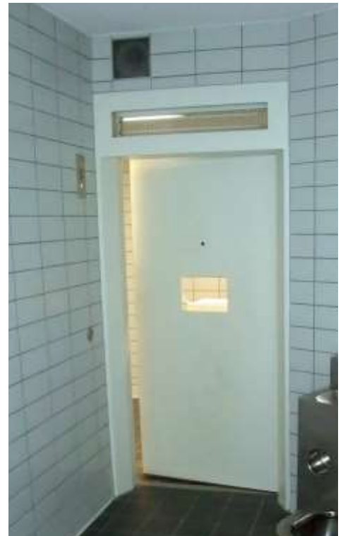
Zellenseite: SÄLZER S4-Z Tür mit Funktionsoberlicht. Die Türen sind flächenbündig montiert und bieten hierdurch zellenseitig keine Ansatzpunkte für Suizidversuche und keine Verletzungsmöglichkeiten.
